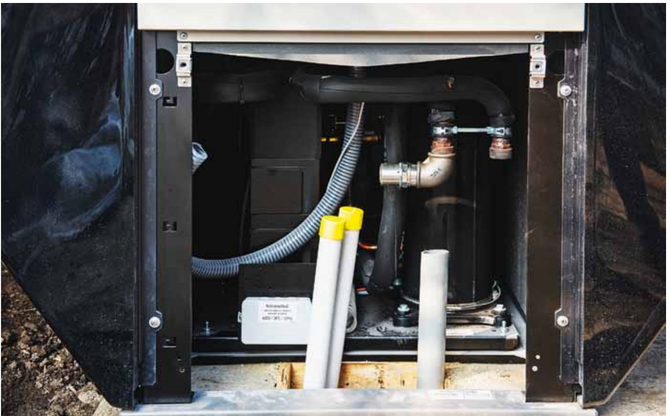
DE BINNENZIJDE VAN DE LUCHT/WATER WARMTEPOMP VAN ALPHA INNOTECH
