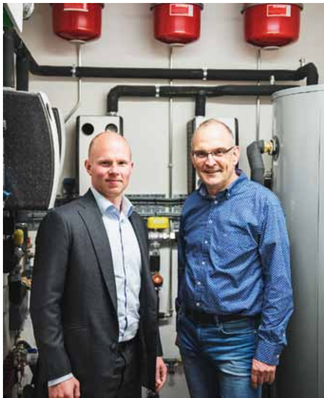
RUUD EN JOS IN DE TECHNISCHE RUIMTE IN HET PAND
