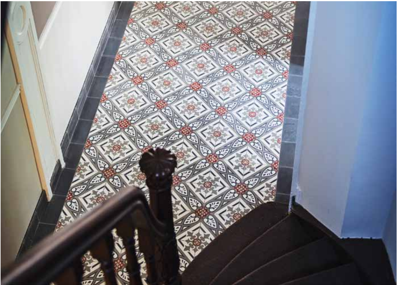
DE TRADITIONELE TEGELVLOER BOVENOP DE VLOERVERWARMING
